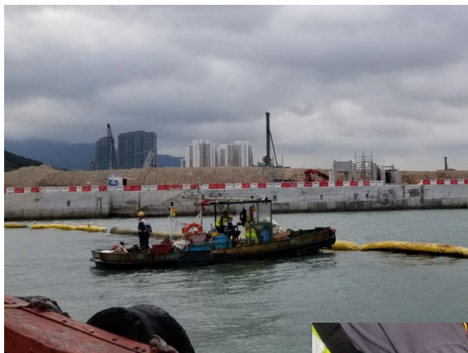
維修及保養淤泥屏障
